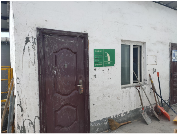
项目污水排放口
