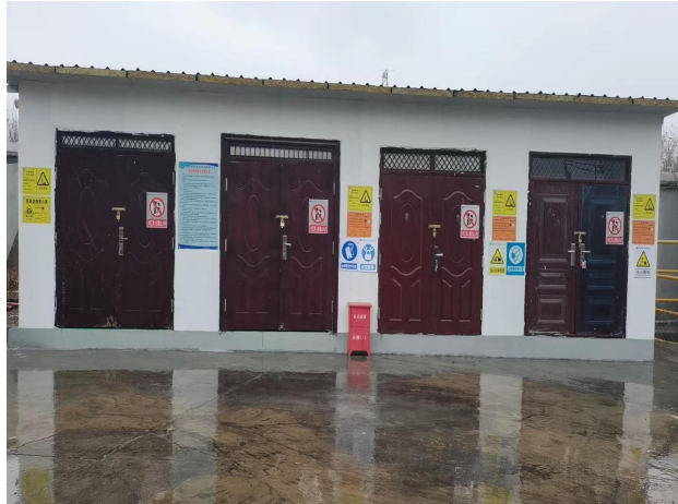
项目危废暂存间
